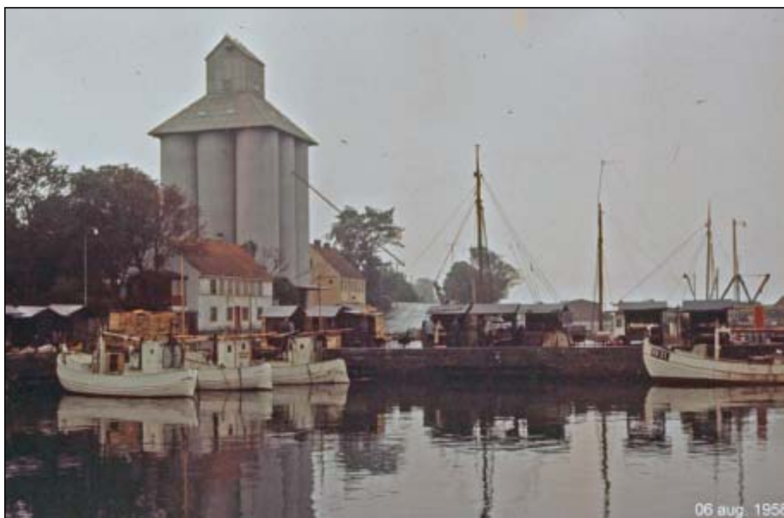
To-etages gadehuse med horisontal orientering danner en rolig kontrast til siloens vertikale volumen. - Fotografiet er fra 1958. Bygningen til venstre for betonsiloen er senere nedrevet
